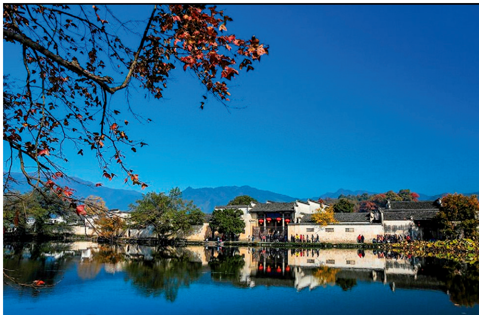
图1 古建筑损坏情况
